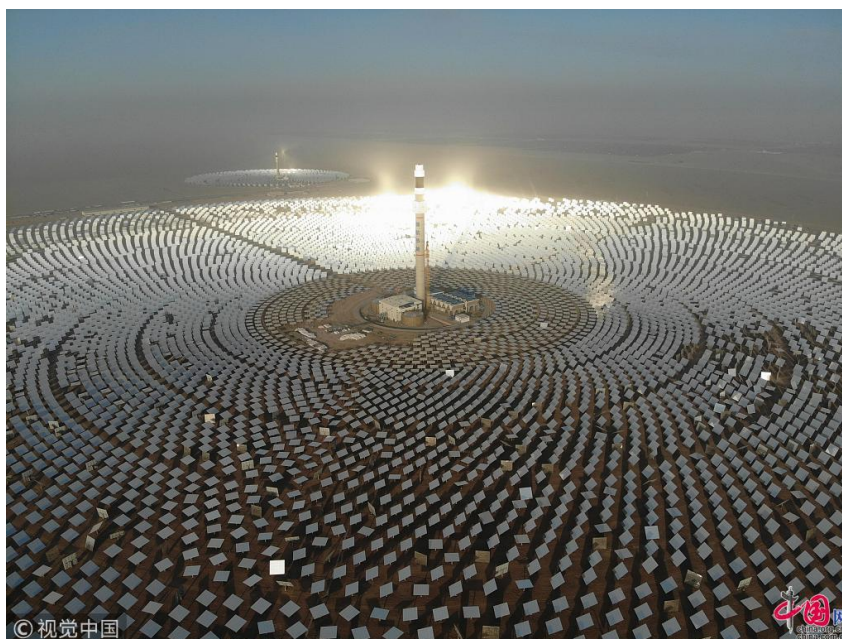
Centrale solaire thermique à sels fondus à tour de 100MW à Dunhuang Chine
