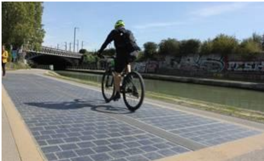
© Piste cyclable équipée de dalles photovoltaïques à Bobigny. Photo F.Pouliquen/20Minutes
