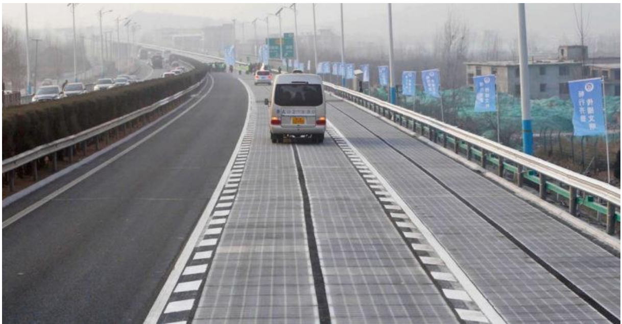
© Jinhan expressway en Chine, une autoroute destinée à produire de l'énergie électrique renouvelable. Des panneaux photovoltaïques ont été installés sur 2 km de voies.
