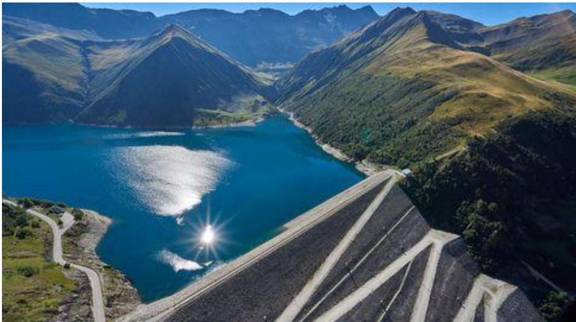
Le barrage de Grand'Maison en France est connecté par des galeries souterraines à une seconde retenue, 930m plus bas. Pomper l'eau en altitude vers ce lac artificiel permet un stockage gigantesque d'eau, et donc d'électricité. ©EDF
