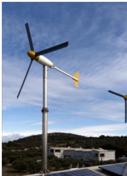
Eolienne à axe horizontal
