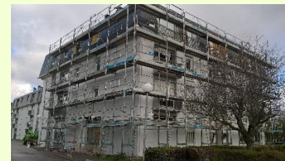
Rénovation de copropriétés
