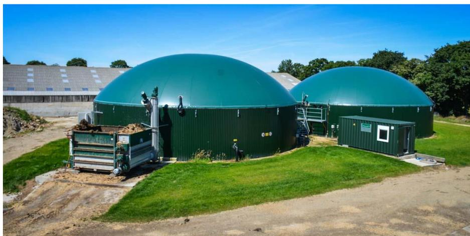
Pendant 25 à 50 jours, ces matières organiques sont placées à l'intérieur d'une cuve, le digesteur, qui est chauffée [40°C] et brassée en l'absence d'oxygène. Elle produit ainsi une énergie renouvelable, le biogaz, et un fertilisant, le digestat.
