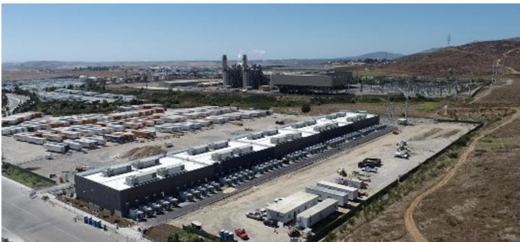
Gateway energy storage en Californie. [©LS Power]. Cette installation de 250 MW devrait pouvoir stocker jusqu'à 1 000 MWh d'électricité, une fois finalisée [le site serait actuellement capable de stocker 250 MWh d'électricité, pouvant ainsi restituer durant 1 heure l'électricité stockée].
