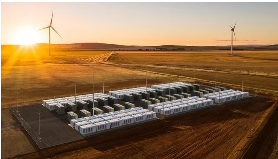
L'installation de Tesla en Australie [150 MW de puissance/193,5 MWh de capacité de stockage], associée au parc éolien de Hornsdale [exploité par le groupe français Neoen]. [©Tesla]
