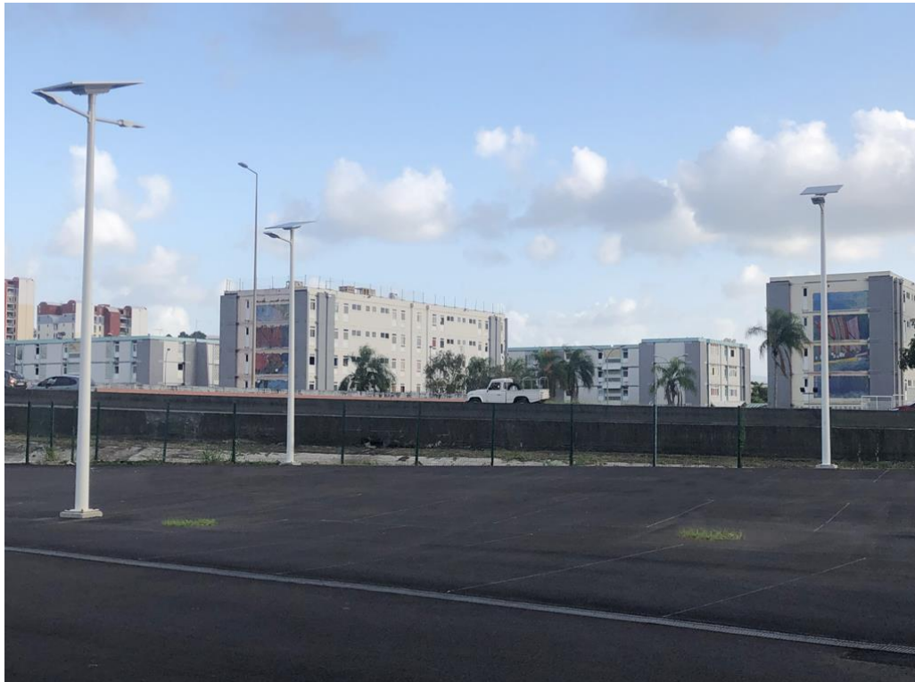
© Lampadaires solaires Novéa éclairent un parking de Martinique
